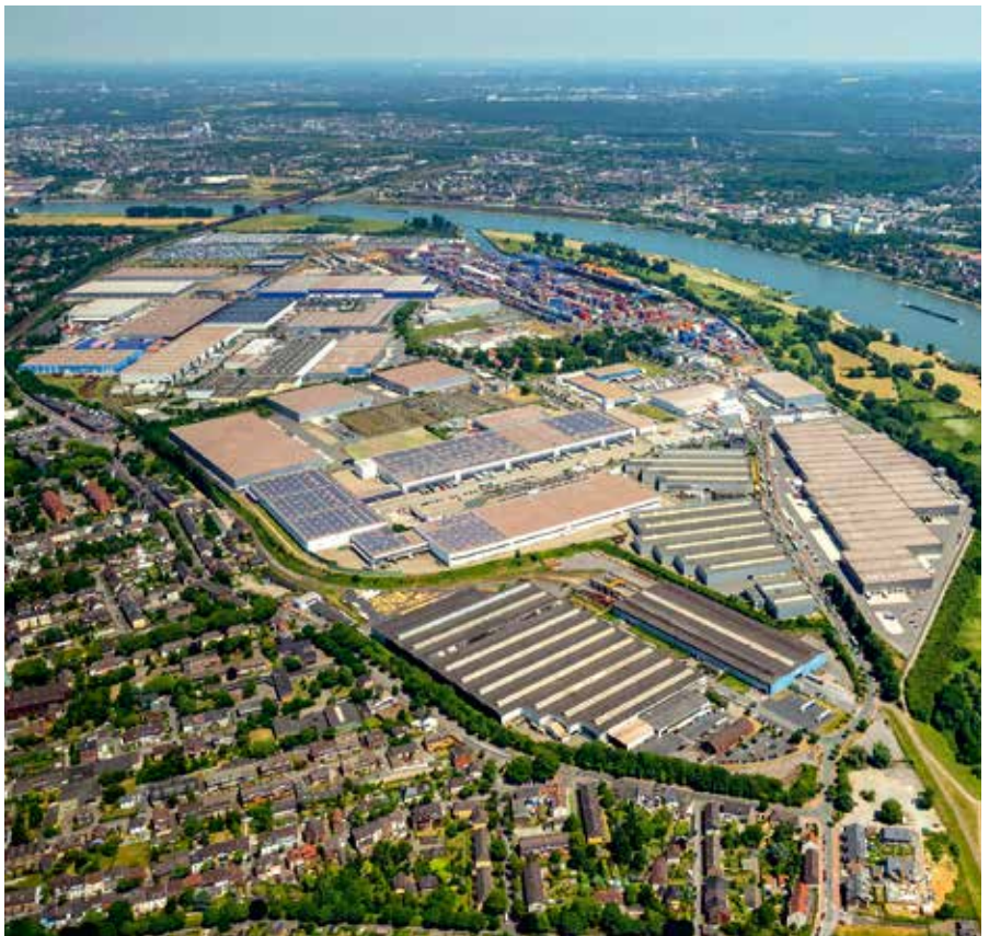
Das logport I-Gelände in Duisburg-Rheinhausen ist komplett vermarktet. Von hier verkehren auch die Chinazüge Foto: Hans Blossley
